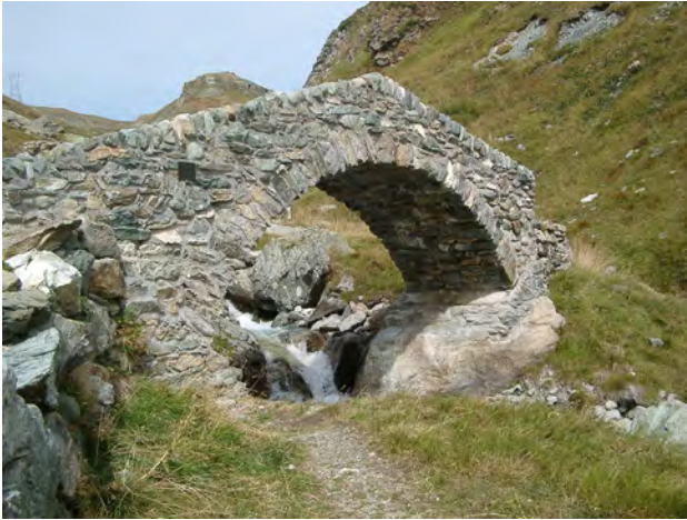
Neue Brücke am Septimerpass Südseite
